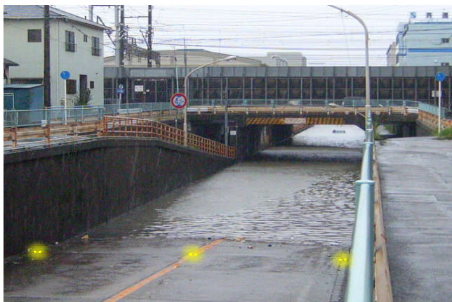
↑ アンダーパスの最高水位箇所に
